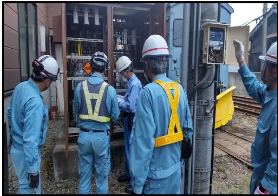
変電所点検についての訓練
