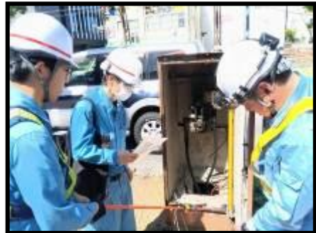
断路器の取り扱いの訓練
